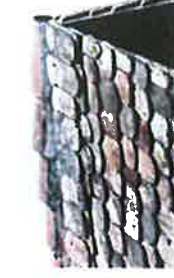
Couverture à double recouvrement
