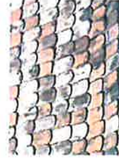
Couverture à simple recouvrement
