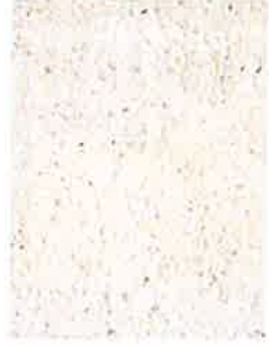
Enduit à la chaux brossé pour faire ressortir les gravillons de sable
