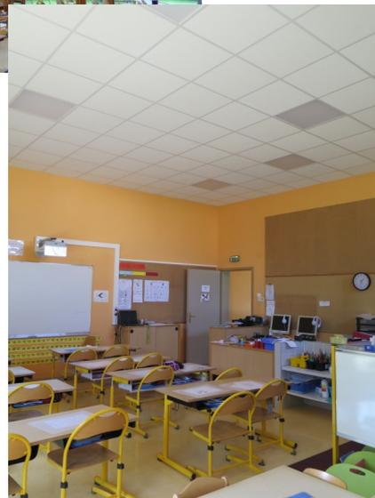
Mise en place de « faux plafonds » dans trois salles de classe, afin d'améliorer l'isolation phonique et thermique et équipement d'un éclairage à leds.
