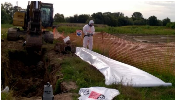
Désamiantage de l'ancienne canalisation intercommunale en août 2018
