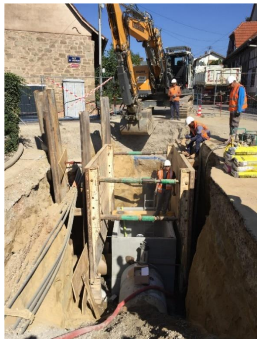
Travaux au croisement de la rue Albert Schweitzer et de la rue du Ruisseau en septembre 2018.
