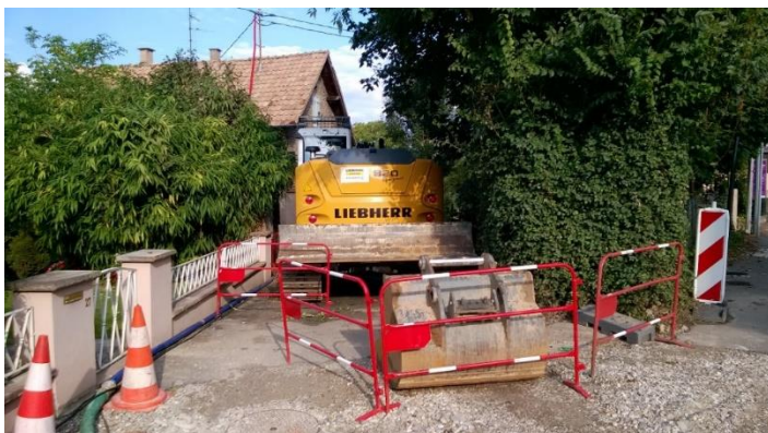
Travaux rue des Prés en septembre 2018
