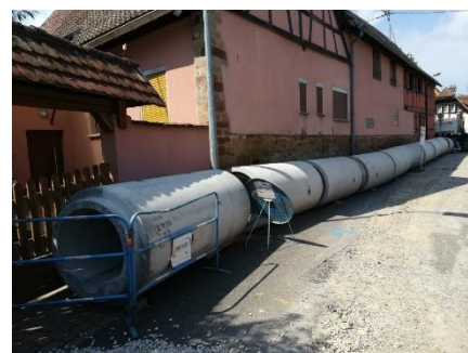
Canalisations en béton de diamètre 800 mm avec cunette prêtes à être posées rue Albert Schweitzer
