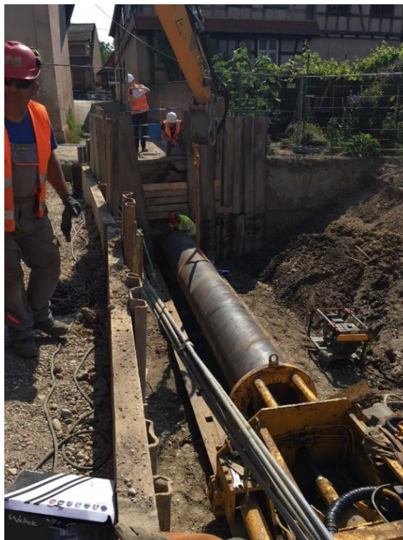
Forage à la tarière en juillet 2018 rue du Ruisseau
