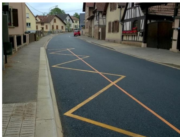
Réfection de la rue du Général Leclerc en mai 2018
