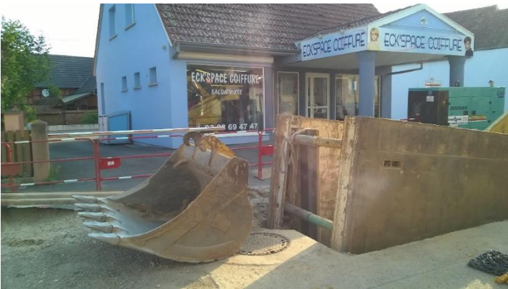
Travaux rue du Général Leclerc d'avril à mai 2018
